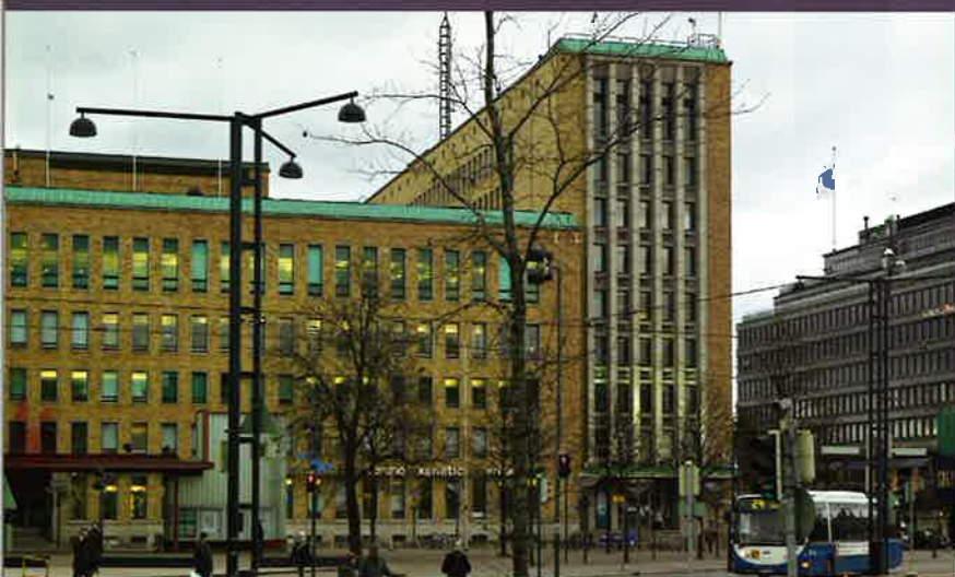
▲ Voormalig hoofdkantoor van Helsinki (renovatie Helin & Co) ▲▲ Uitbreiding van het parlementsgebouw (Helin & Co)
